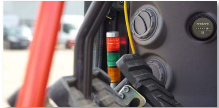
Eine Ampel im Blickfeld des Baggerführers zeigt, ob sich die Schaufel zu hoch oder zu niedrig befindet.
