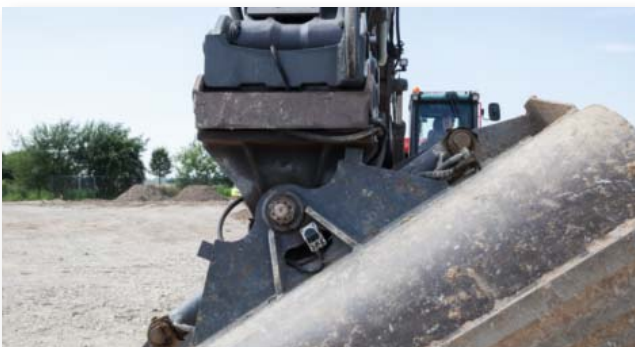
Auch die Querneigung der Baggerschaufel wird in der Berechnung berücksichtigt.
