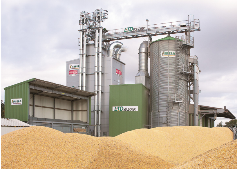
Bild 1: Riela Getreidetrocknungs- und lageranlage
